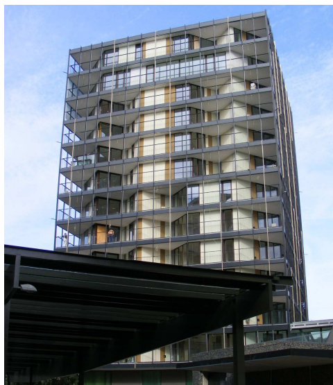
Obr. 1 Budova obytného komplexu Central Park, Praha Žižkov
