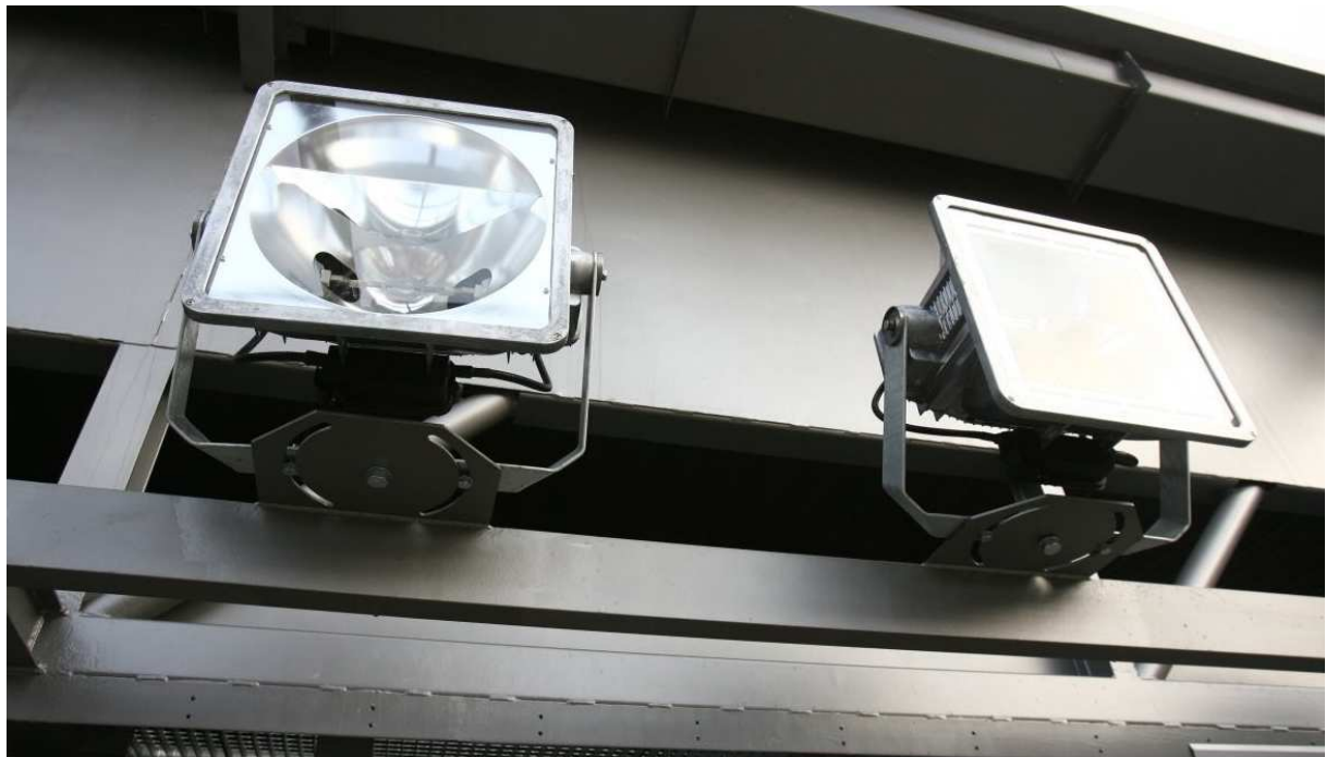
obrázek 4: Uchycení světlometů na střešní konstrukci
