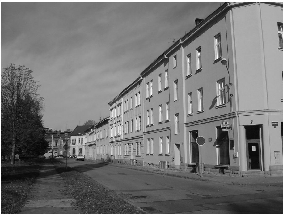
Obr. 11 Původní osvětlení ul. Jirská
