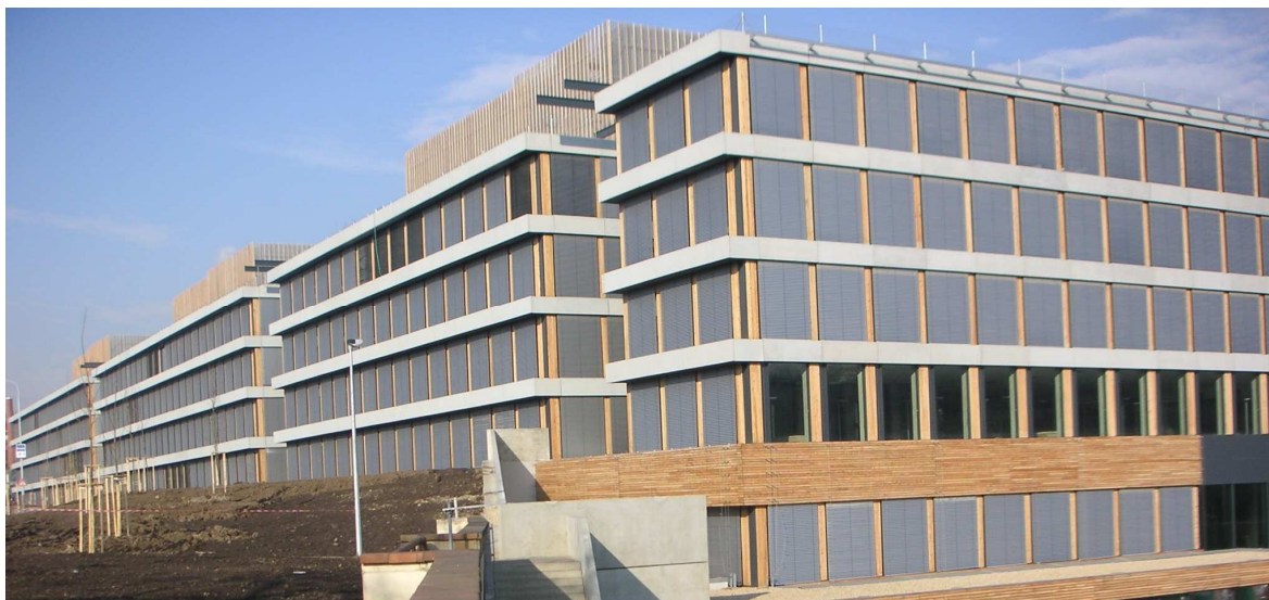
• Obr. 6: Budovy vybavené venkovními lamelovými žaluziemi
