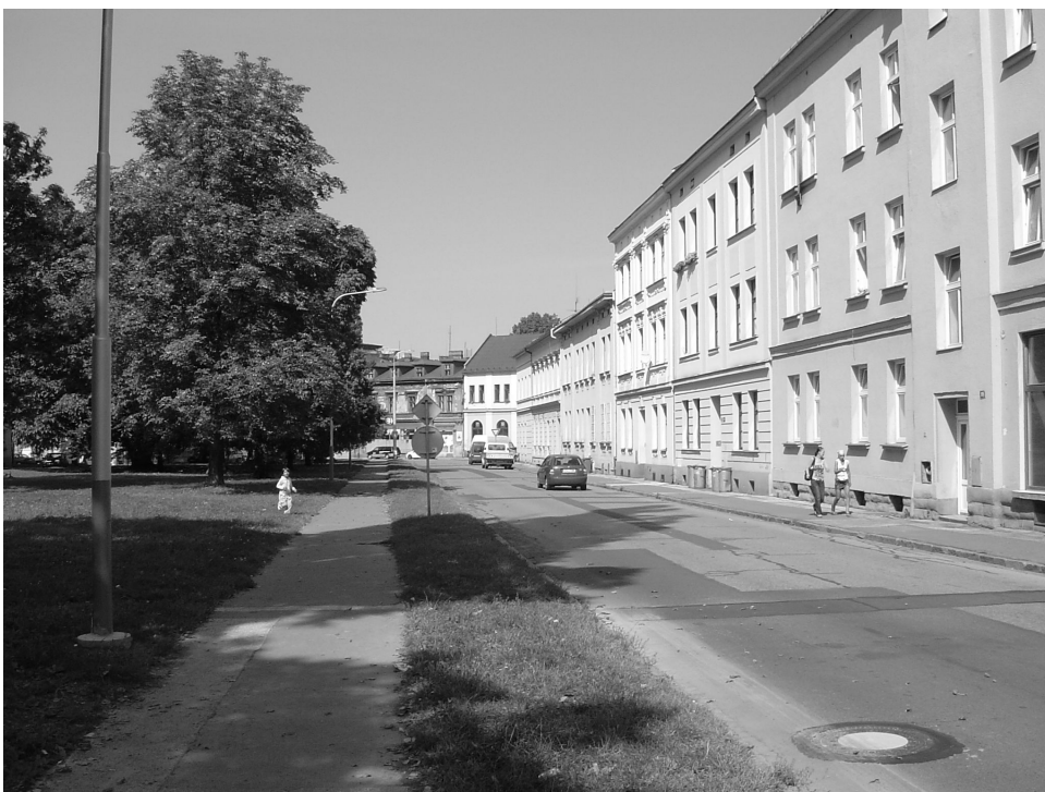
Obr. 12 Stav osvětlovací soustavy po rekonstrukci
