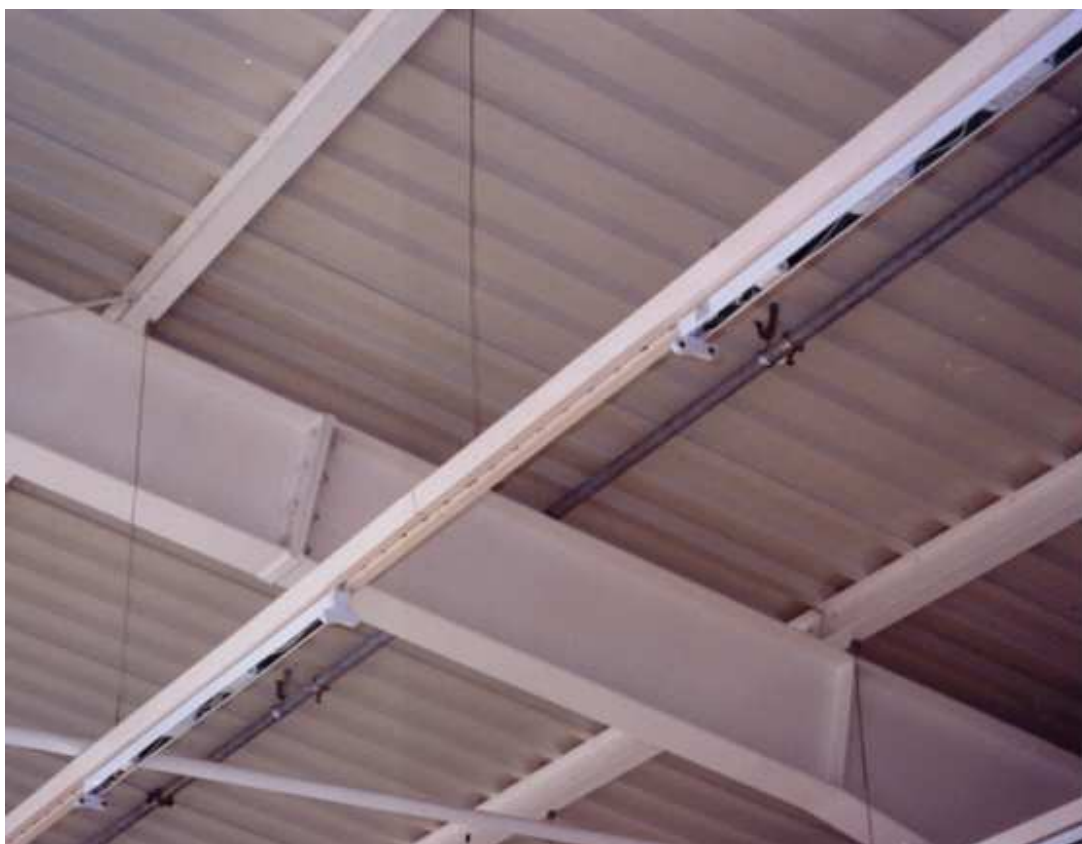
• Obrázek 1: Nosník svítidel OBO LTK pod stropem výrobní haly
